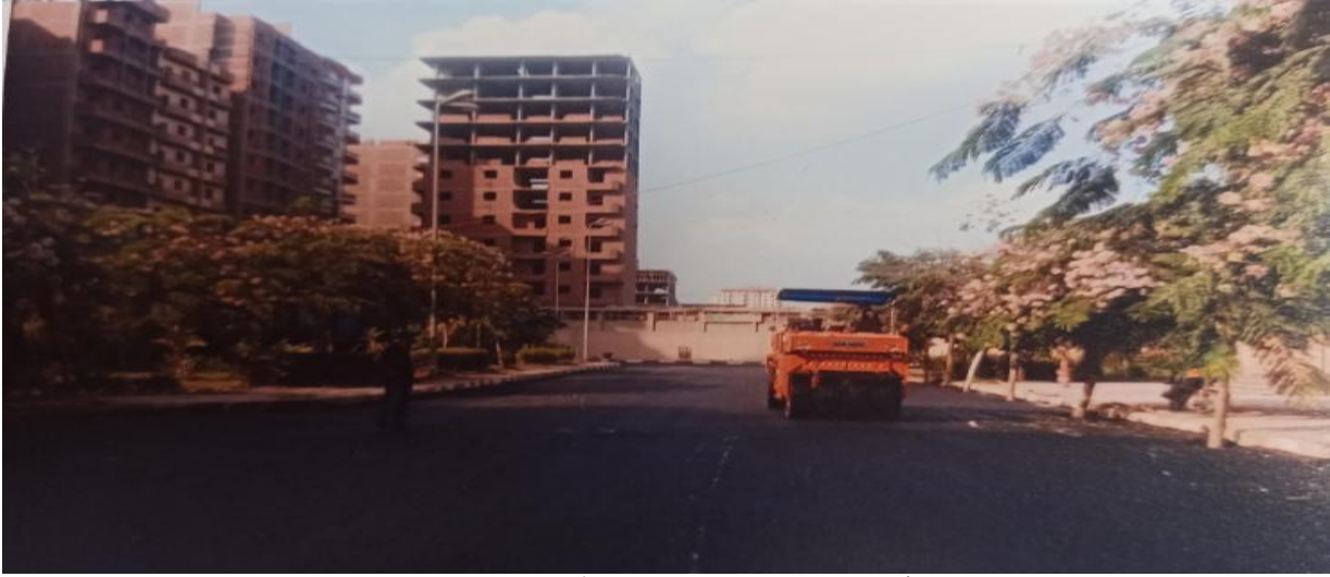
أثناء مباشرة رصف الكلية من الداخل
